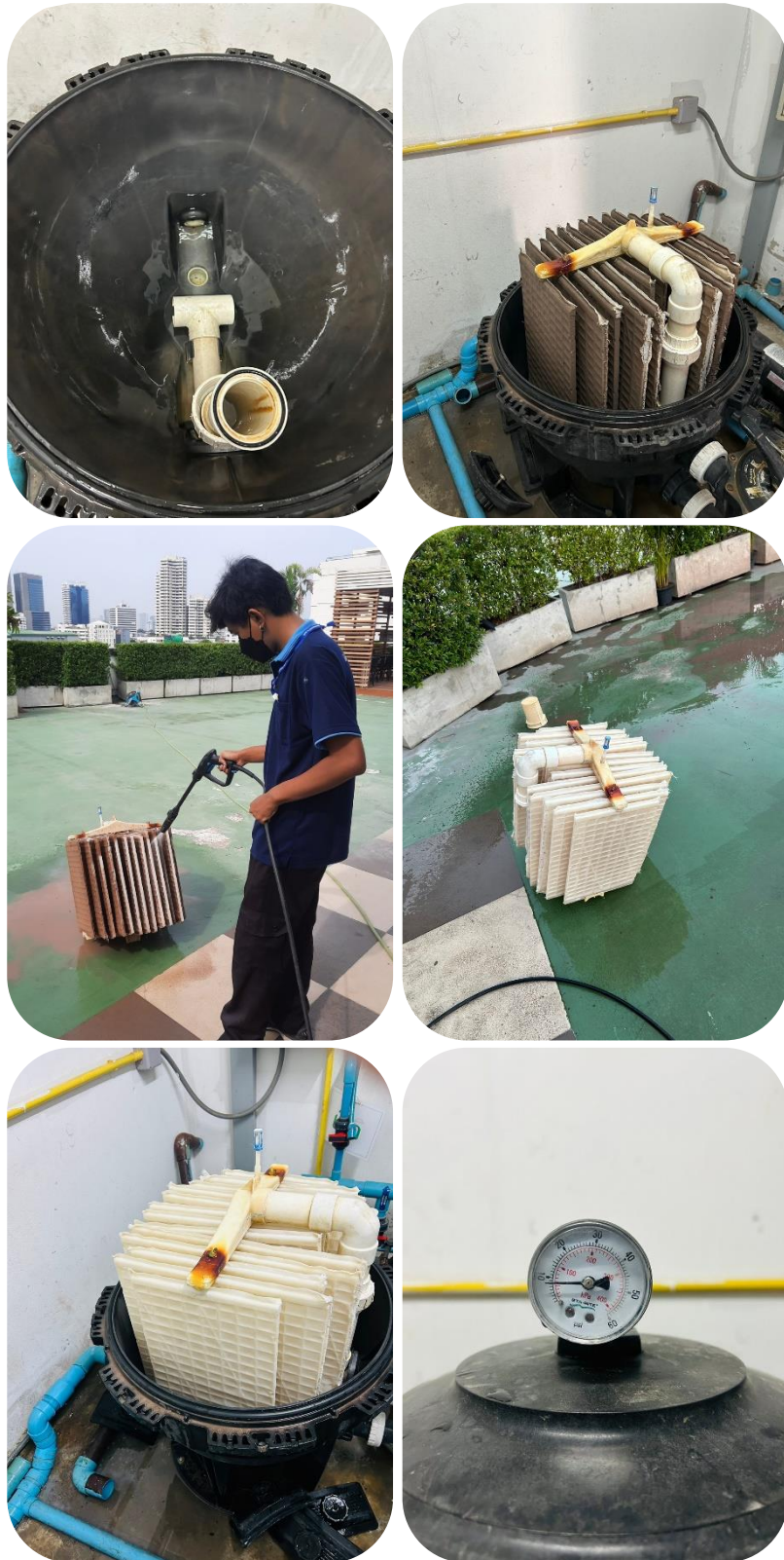
ภาพที่ 4.2-4 ทำความสะอาดถังกรองทรายน้ำ
