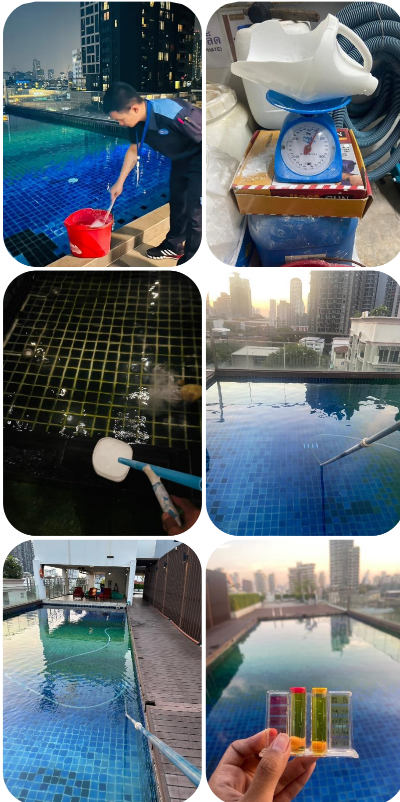
ภาพที่ 4.2-3 เติมคลอรีน ทำความสะอาดสระว่ายน้ำ และตรวจเช็คคุณภาพน้ำ
